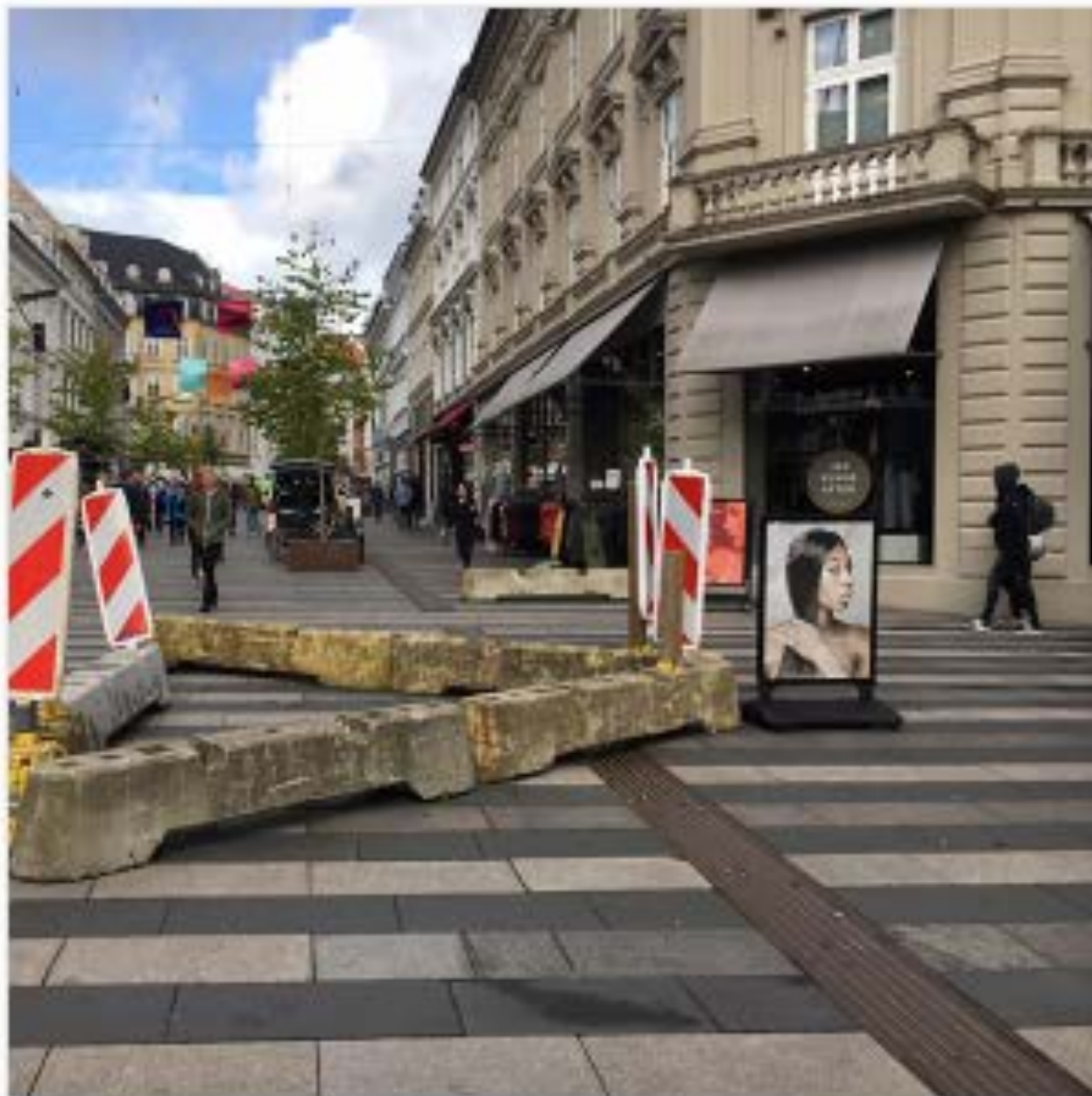
Terrorsikring på Ryesgade i Aarhus
